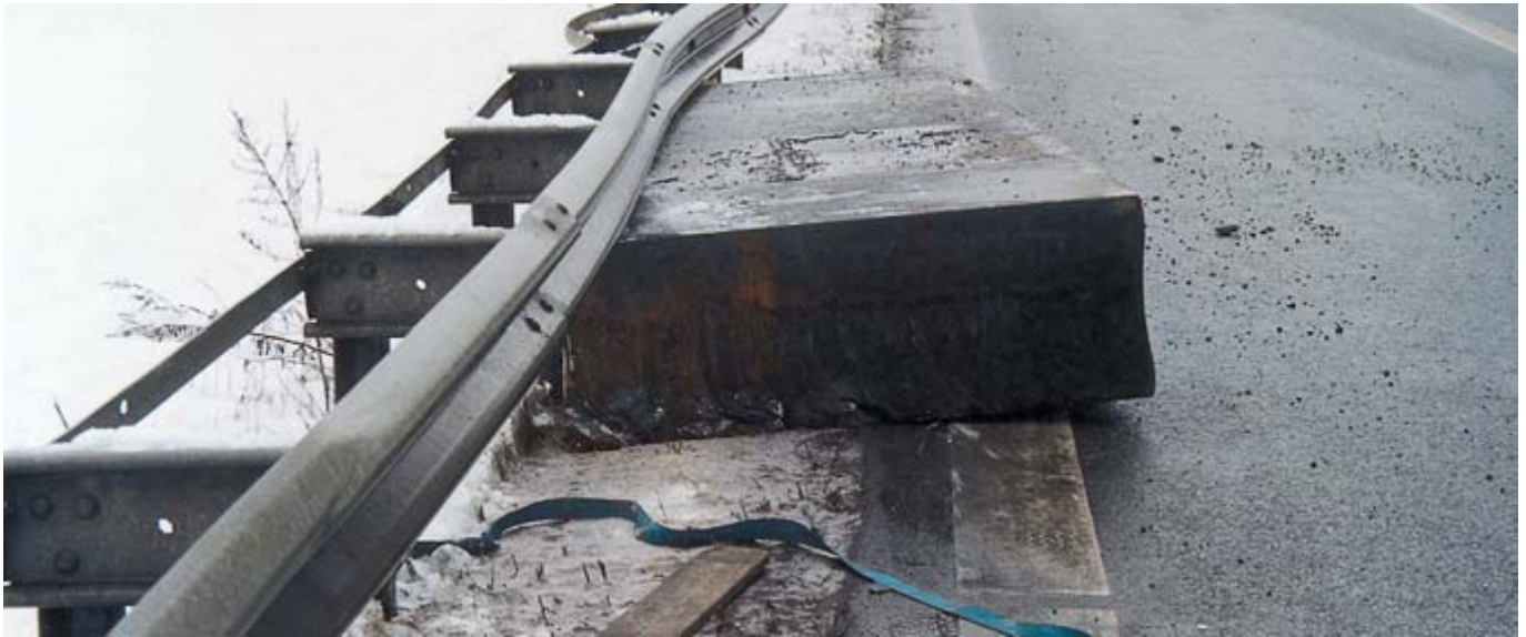
Die massive Bramme rutschte quer über die Fahrbahn und wurde erst durch die Mittelschutzplanke gestoppt.
