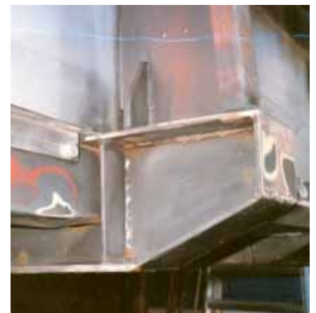
So kann eine verstärkte Stirnwand aussehen.
