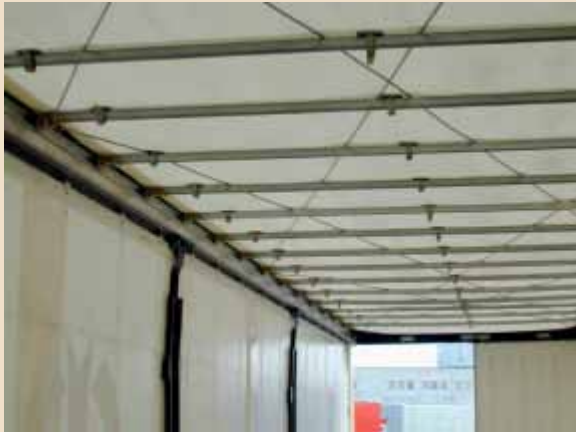
▶ Dieses Dach ist durch Drahtseile verstärkt.
