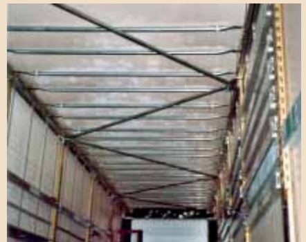
▼ Dieses Dach ist durch diagonal verlaufende Metallstangen verstärkt.
