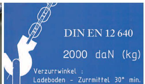
Kennzeichnung eines Zurrpunktes gemäß der DIN EN 12640 (Beispiel)
