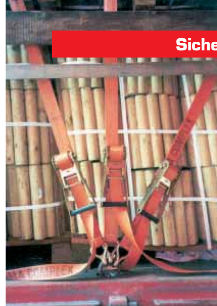
Es kommt nicht auf die Anzahl der Zurrgurte an, sondern darauf, wie viel Kraft eingeleitet wird.
