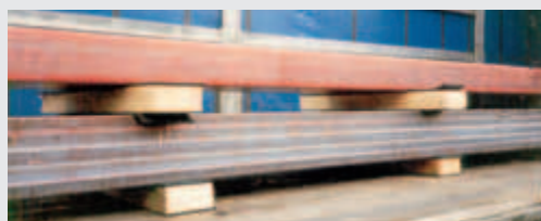
Antirutschbalken dienten als Auflage.
